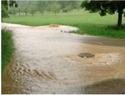
Da in dem RÜB I ein so hoher Druck besteht, sind die Deckel verschraubt.
