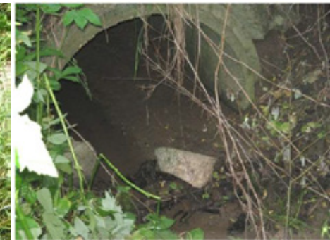
Dole unter der L 1152 die Hälfte ist mit fester Erde verstopft.
