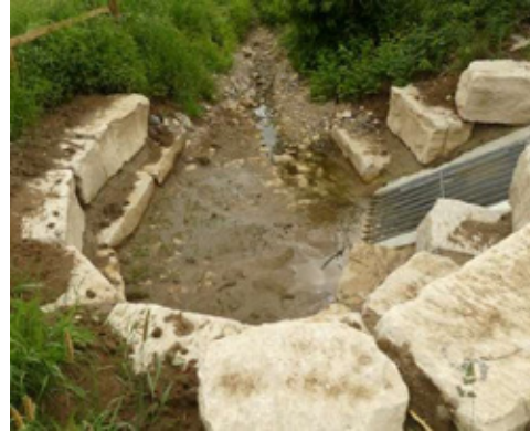
Blick auf den Klingelbrunneneinlauf
