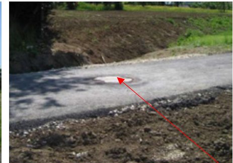
Erster Schacht nach dem Dammbach
