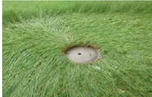
Da in dem RÜB I ein so hoher Druck besteht, sind die Deckel verschraubt.
