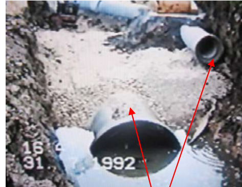
Rohr für Schmutzwasser Rohr für Quellwasser
