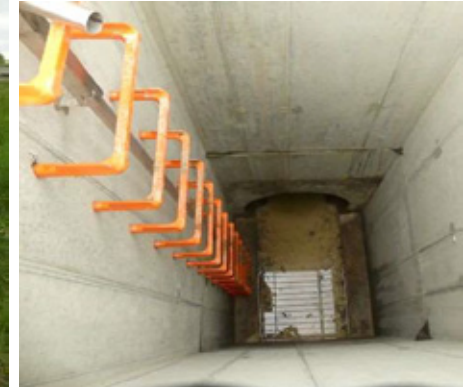
Not-Einlauf Blick von oben
