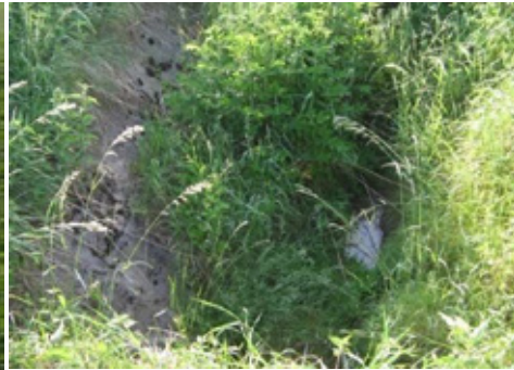
Einlaufbereich vor der L 1152
