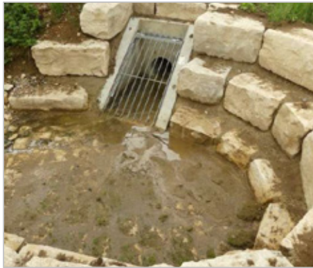
Ablauf zum Dammbach
