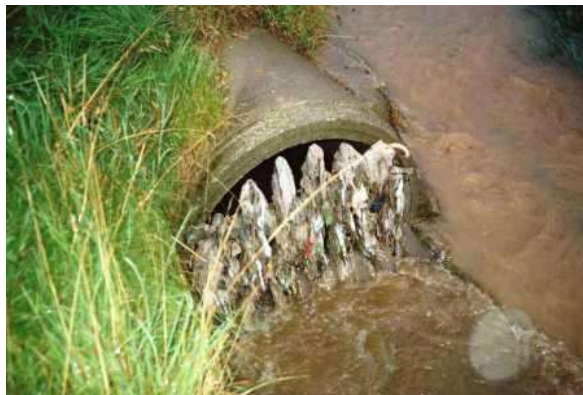
Verschmutztes Gitter am Auslauf des RÜB I
