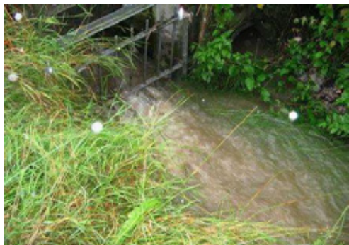
Das RÜB I konnte sich ungehindert entleeren.
