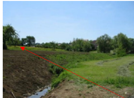
Letzter Schacht vor dem Dammbach
