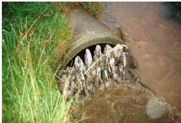
Verschmutztes Gitter am Auslauf des RÜB I
