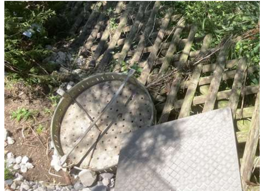
Diesen Gullydeckel von dem Kanalisationsrohr zum Quellweg hat es gelupft und den Schmutzfänger gleich mit. Somit trat zusätzlich zu dem Oberflächenwasser des RRB, das verdolte Wasser an die Oberfläche.
