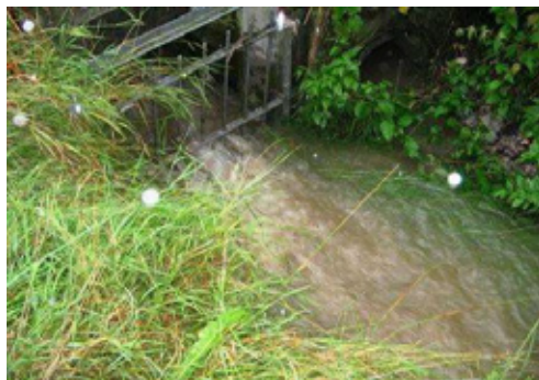
Das RÜB I konnte sich ungehindert entleeren.
