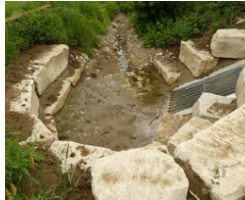
Blick auf den Klingelbrunneneinlauf
