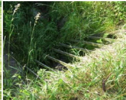
Einlaufgitter vor der L 1152
