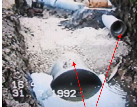
Rohr für Schmutzwasser Rohr für Quellwasser
