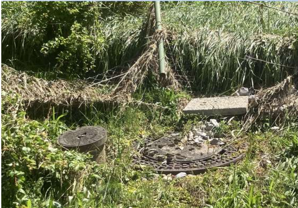
Diesen Gullydeckel von dem Kanalisationsrohr zum Quellweg hat es gelupft und den Schmutzfänger gleich mit. Somit trat zusätzlich zu dem Oberflächenwasser des RRB, das verdolte Wasser an die Oberfläche.
